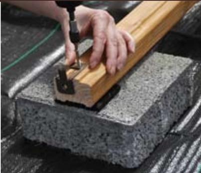
Durch die Klammer erhält man bei der Montage einen idealen Abstand von 5 mm, welcher auch einen späteren Austausch einzelner Profile ermöglicht.
