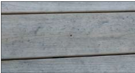
Verfärbungen auf der Holzoberfläche durch Eisenspäne
