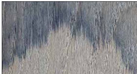
Ausbleichen der Verfärbungen mittels Oxalsäure
